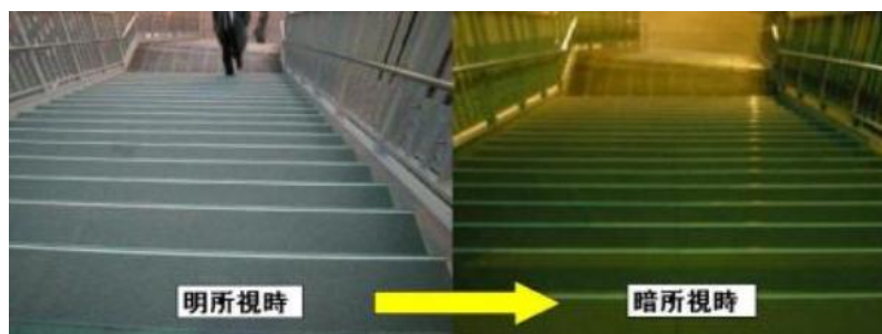
高輝度蓄光式防滑階段施工例
