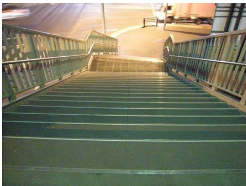
歩道橋施工例写真
