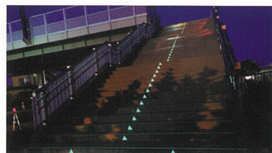
吉田町住吉地区 津波避難タワー(夜間下から)
