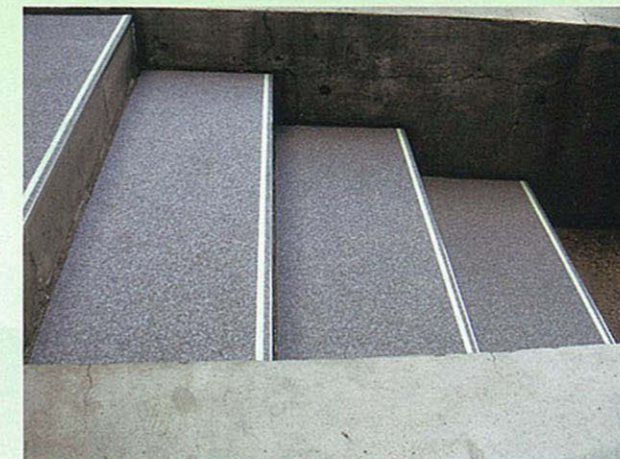
写真3 高輝度蓄光段鼻材の施工事例
