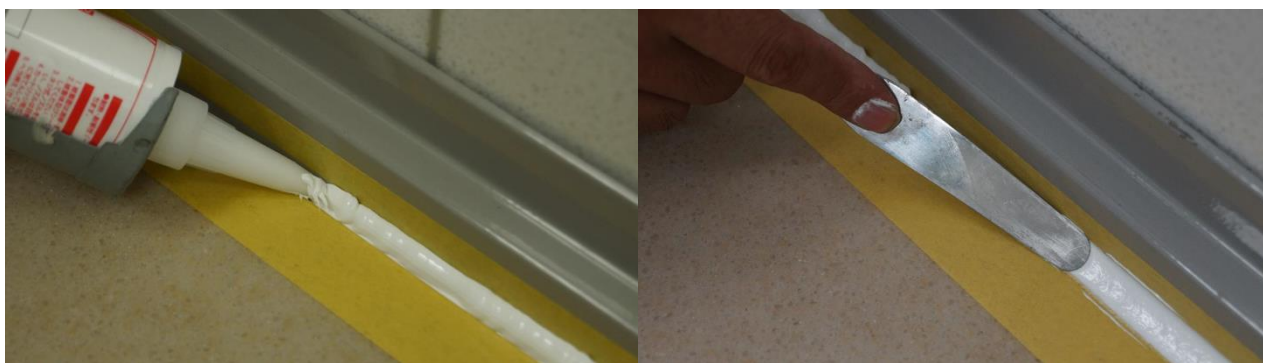
シーリング状況
