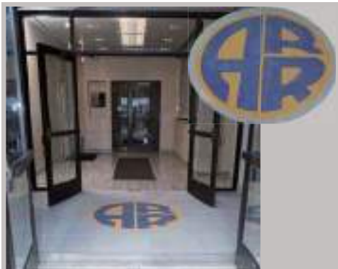
直径1200mmの大板サイズでの象嵌一体成形が可能です。更に、表面の防滑仕上げが滑りによる転倒事故を未然に防ぎます。
