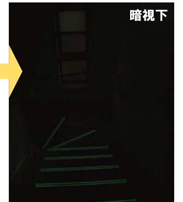
木製階段の段鼻に溝を掘り設置
