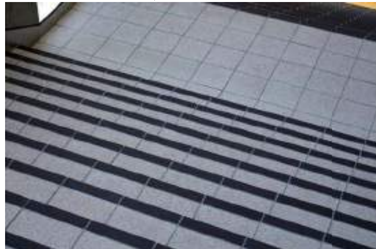
▼ 京王電鉄飛田給駅階段 リフォーム施工例
