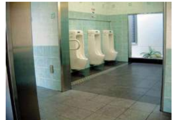
▲ 高速道路内パーキングエリア アンプロップ:トイレ床面への施工例
